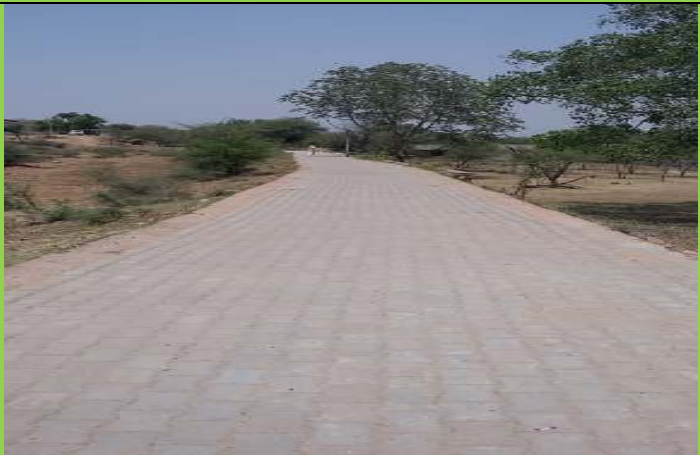
इन्टर लॉकिंग टाईल खरंजा निर्माण
