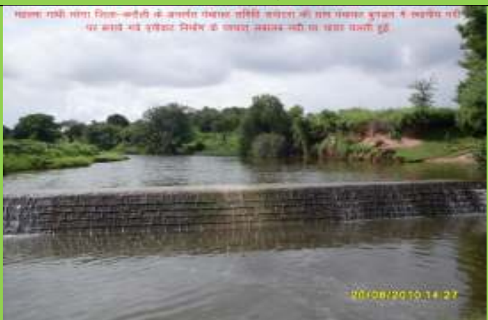
जिला करौली पं.स. सपोटरा में एनीकट निर्माण
