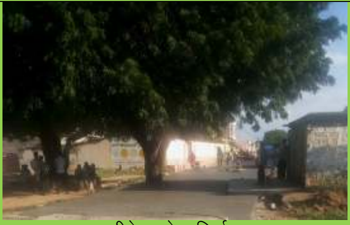
सीमेन्ट रोड निर्माण
